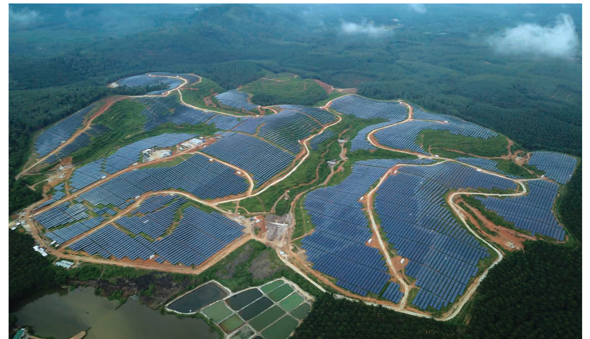
△ 马来西亚 62MW 光伏电站项目
