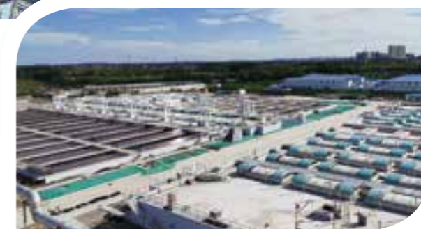
◆ 亚洲最大的污水处理厂 - 上海白龙港提标改造工程
