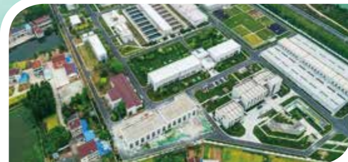
◆ 常州魏村水厂深度改造工程
