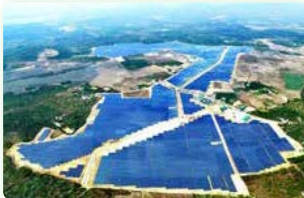
◆ 承建的越南格桔 62MWp 光伏电站提前通过测试并验收，正式投入商业运营
