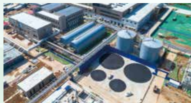
◆ 南京江北废弃物综合处置中心项目
