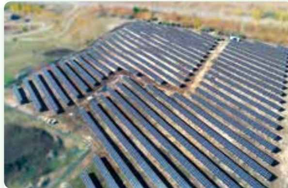
◆ 由苏美达提供光伏组件的亚美尼亚单体最大光伏电站贺拉兹丹 2.2MWp 光伏电站顺利并网，正式进入商业运营
