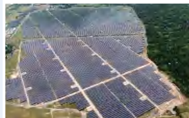
越南Saomai 二期106兆瓦光伏电站项目
