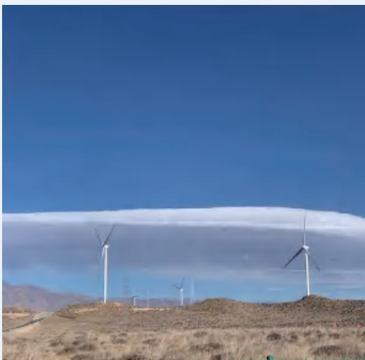
青海切吉 50MW 高原风电项目
