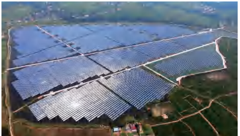
安徽肥东40MW渔光互补电站
