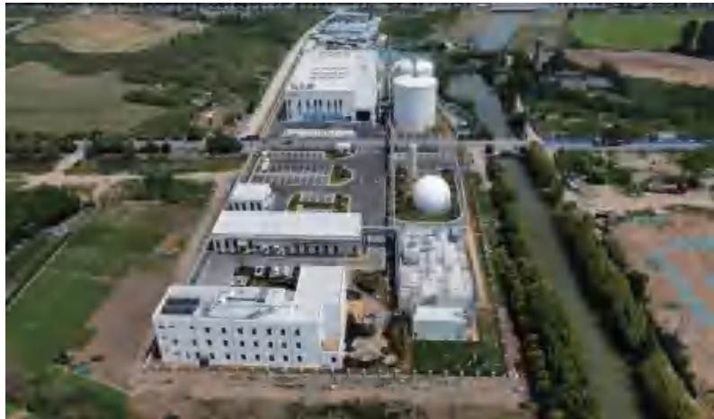
南京栖霞区餐厨垃圾处理项目
