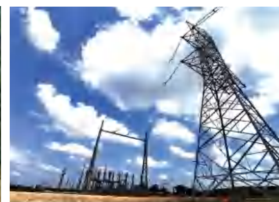
OMVG西非四国跨境输电线路工程
